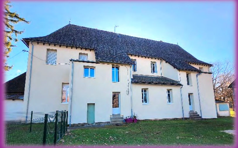
Isolation extérieure de l'école
